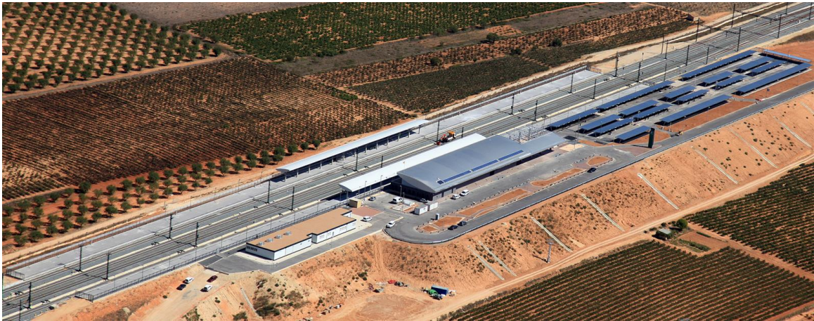
Figura 5.6.c. Unidad de paisaje 3: Urbano Infraestructuras de transporte. Fuente: ADIF
