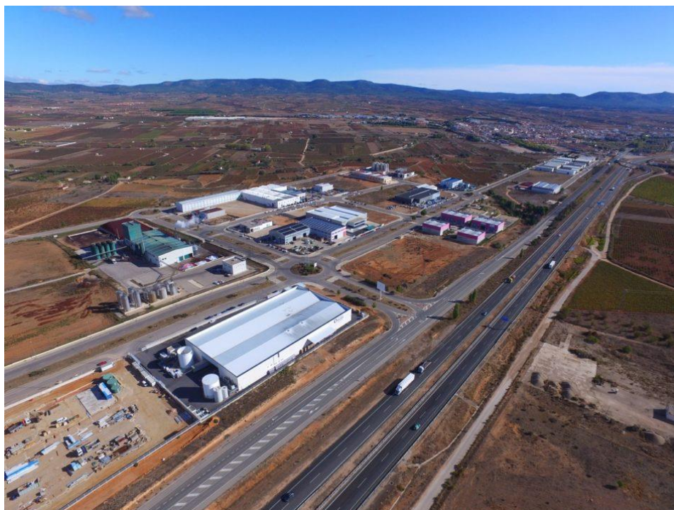
Figura 5.6.f. Unidad de paisaje 6: Infraestructuras industriales. Fuente: Parque Empresarial Nuevo Tollo.
