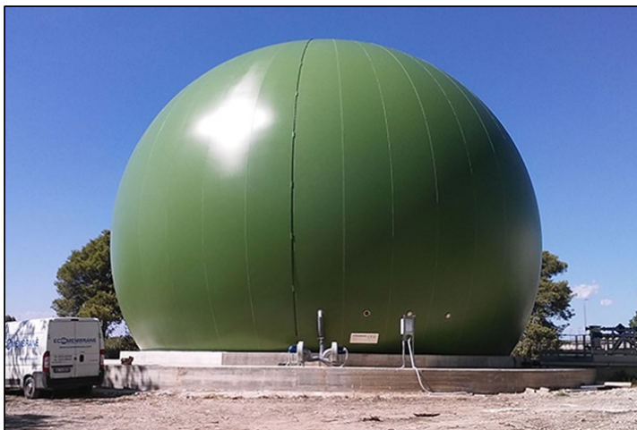
Figura. Membrana de almacenamiento de biogás.
