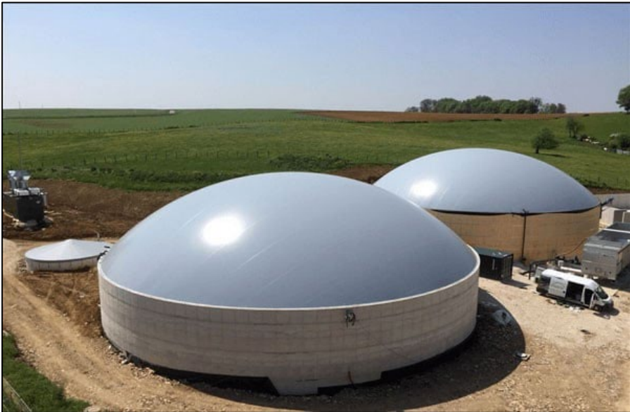
Figura. Post-digestores de hormigón
