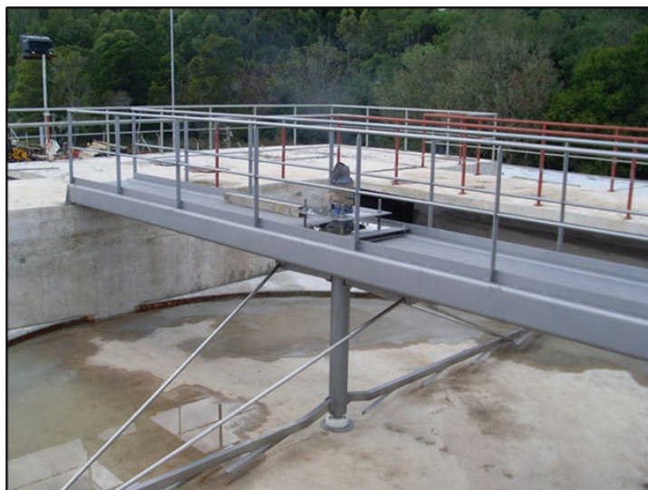
Figura. Sistema de separación de arenas
