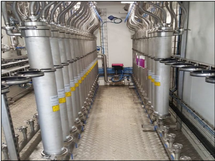
Figura. Upgrading de biogás por membranas (Propio)
