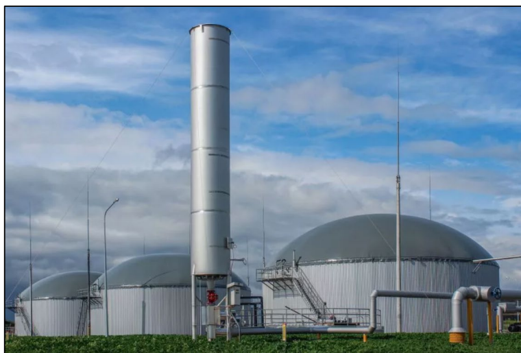
Figura. Antorcha de seguridad. Fuente: Virtus.
