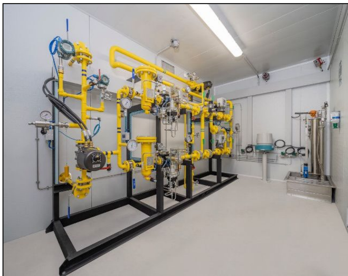
Figura. Módulo de inyección a red. Fuente: Virtus.
